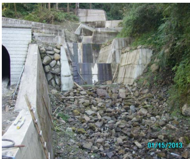
阿里山區 149 林班崩塌地處理工程 (102 年 1 月 15 日現場拍攝)
