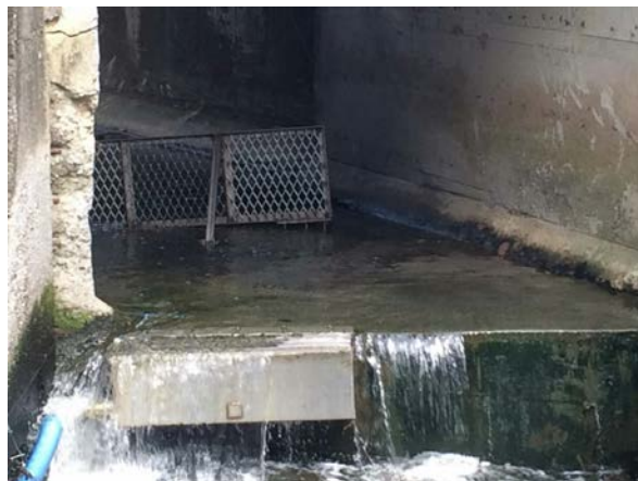
臺南市寮子廊社區民生污水截流工程 (臺南市政府環境保護局提供)
