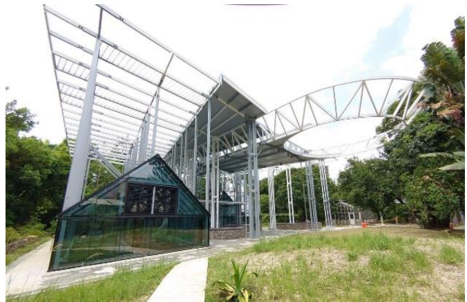
臺北植物園溫室整建工程 （林試所提供）
