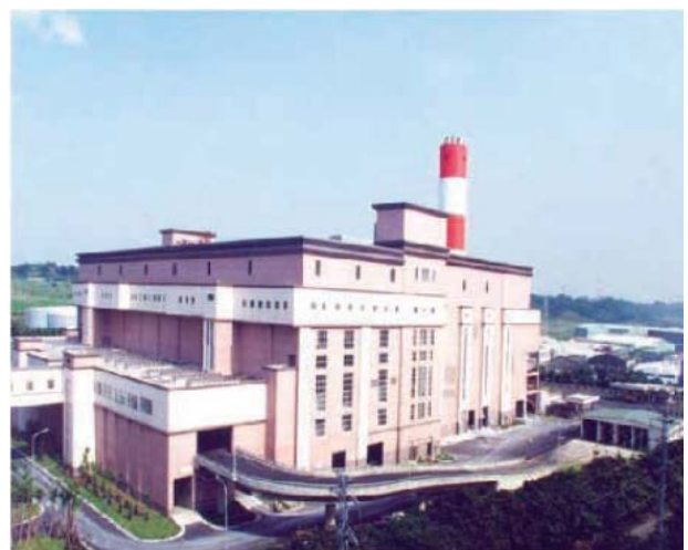
高雄市政府環境保護局南區資源回收廠 (擷取自行政院環境保護署「垃圾焚化廠興建營運紀實」)
