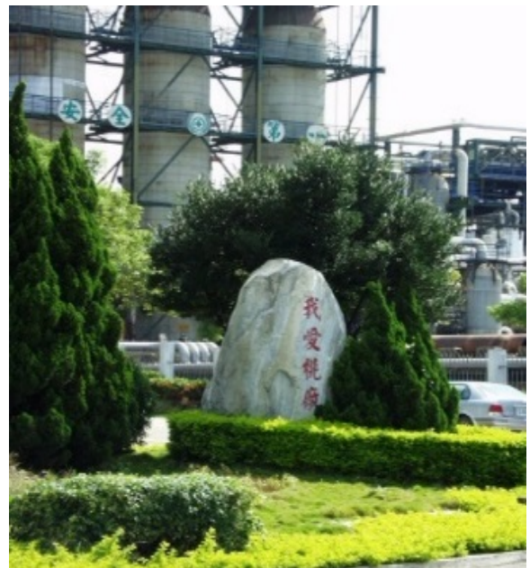
台灣中油股份有限公司煉製事業部桃園廠 (擷取自台灣中油公司網站)
