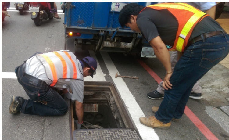
桃園市政府養護工程處查察寬頻管道之手孔 (105年5月5日拍攝)
