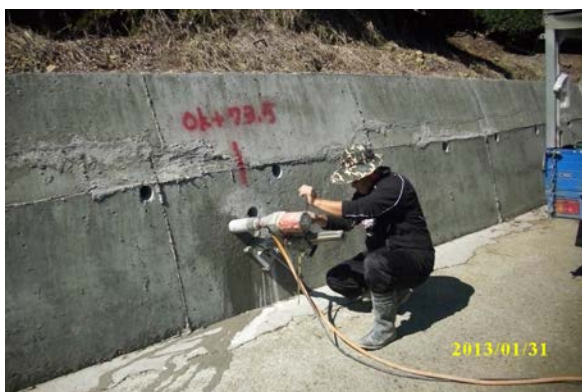
混凝土鑽心取樣情形 (南投縣政府提供)
