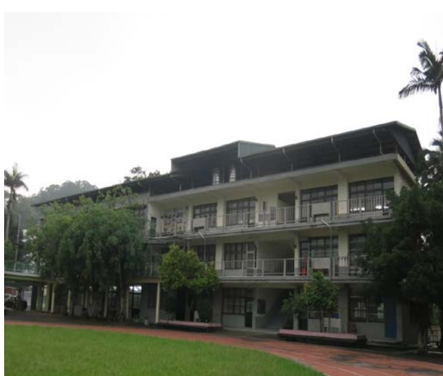
新竹縣立員東國中校舍屋頂防漏工程 (新竹縣立員東國中提供)
