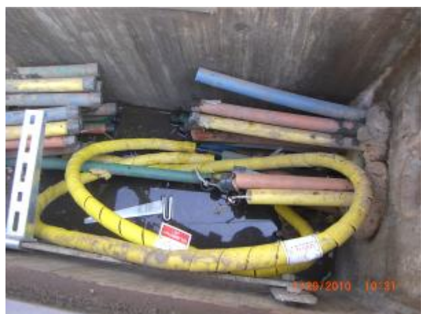
新竹市寬頻管道手孔內部情形 (99年1月29日攝)
