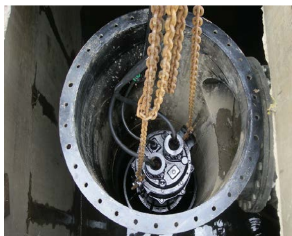
基隆市愛六路等雨水下水道改善工程 (100 年 11 月 24 日攝)
