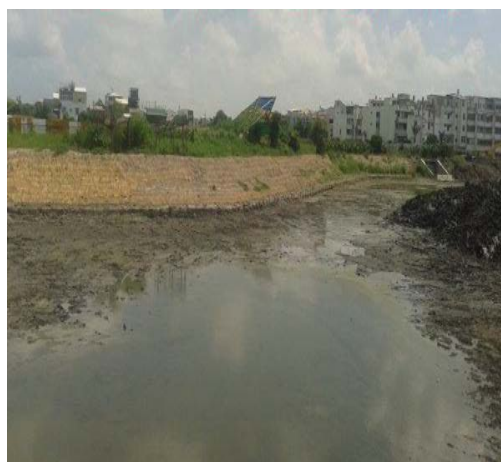
臺南市柳營櫻花社區滯洪池 (臺南市政府水利局提供)
