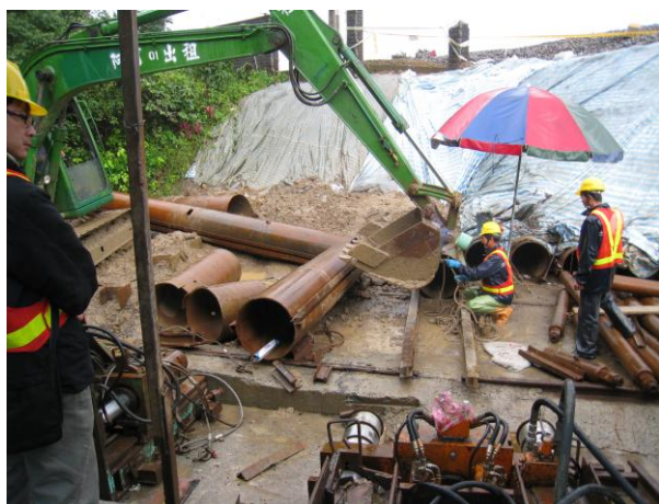
宜蘭線九份坑溪涵洞 23K+200 改建 工程-現場施工情形 (100 年 12 月 16 日拍攝)
