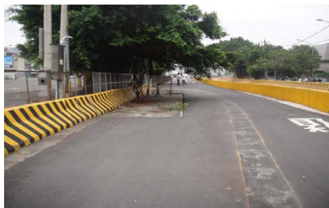
新竹市後火車站觀光夜市 管理室及廁所違章建物拆除後 (新竹市政府產業發展處提供)
