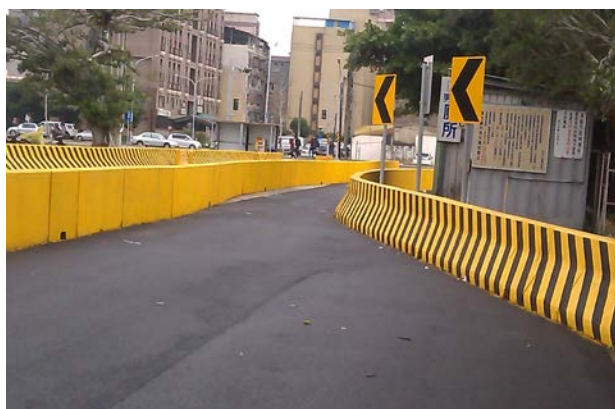
新竹市後火車站觀光夜市 管理室及廁所違章建物拆除前 (新竹市審計室 103 年 12 月 3 日拍攝)
