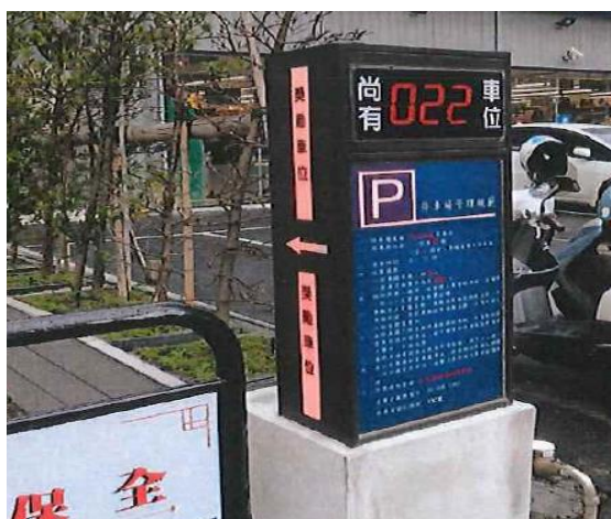
改善後動態剩餘車位顯示裝置設置情形 (新竹縣政府提供)
