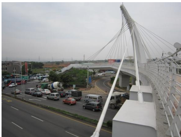
臺中國際機場附近交通繁忙，陸橋完成後改善行人交通安全。 (103 年 4 月 21 日拍攝)
