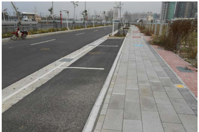
臺中市第 14 期市地重劃第一工區工程完工情形 (臺中市政府建設局提供)
