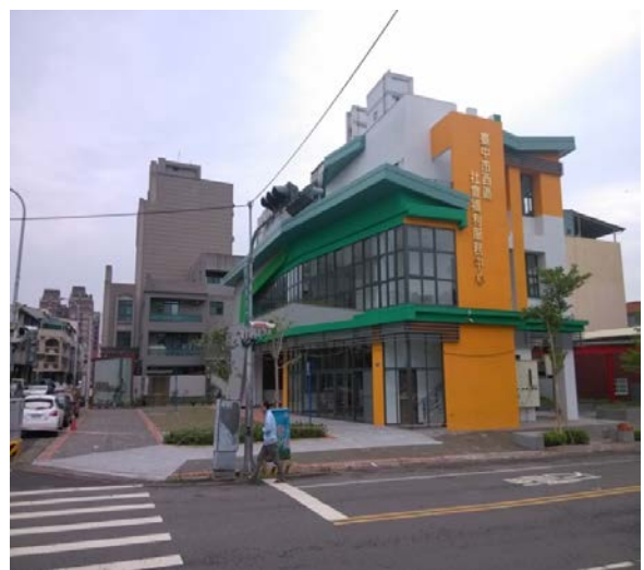
臺中市西區區域性社會福利服務中心 (臺中市政府都市發展局提供)
