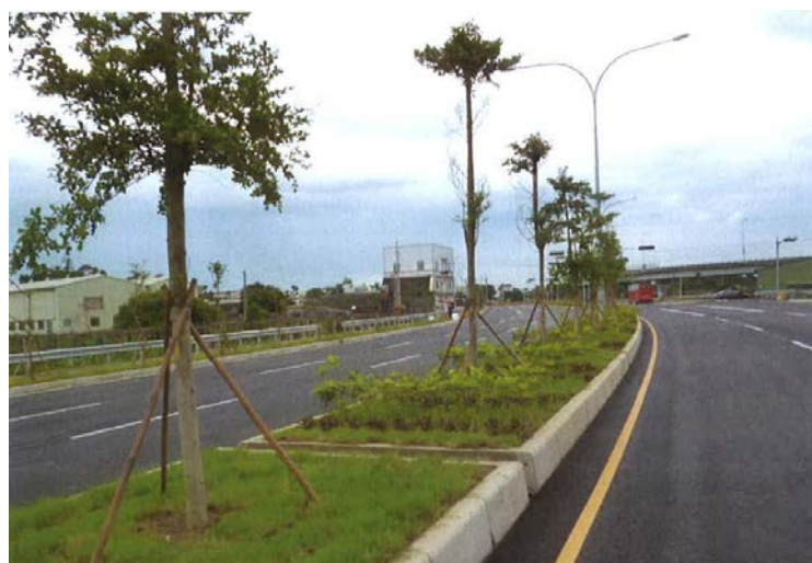
臺中市中科后里園區西向聯外道路工程完工啟用 (臺中市政府建設局提供)
