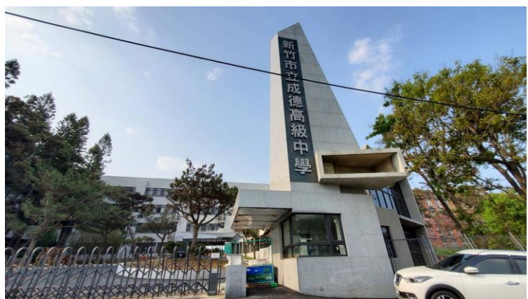
新竹市成德高中老舊校舍拆除重建情形 (新竹市政府提供)
