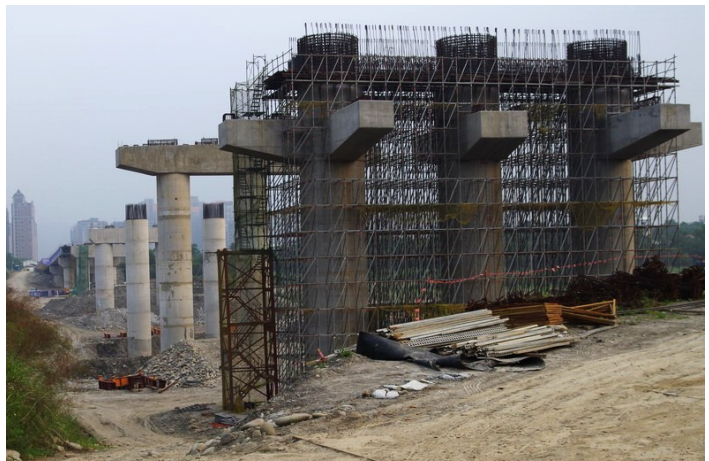
重大公共建設—三鶯二橋新建工程計畫 (新北市政府提供)
