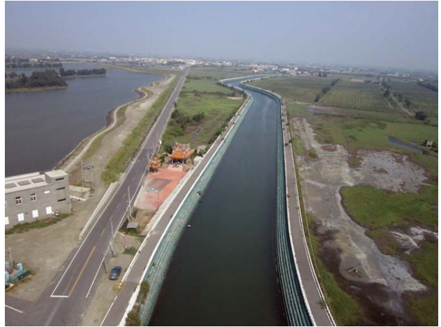
雲林縣尖山大排排水整治工程竣工後情形 （雲林縣政府提供）
