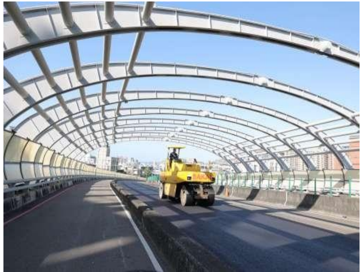
新竹市香山區道路鋪設工程 (新竹市政府提供)
