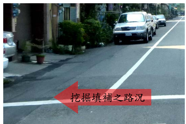
彰化縣田中鎮道路挖掘填補情形 (彰化縣田中鎮公所提供)
