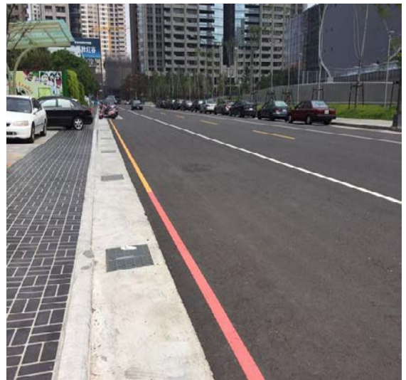
臺中市路平專案已完工路段 (臺中市政府建設局提供)
