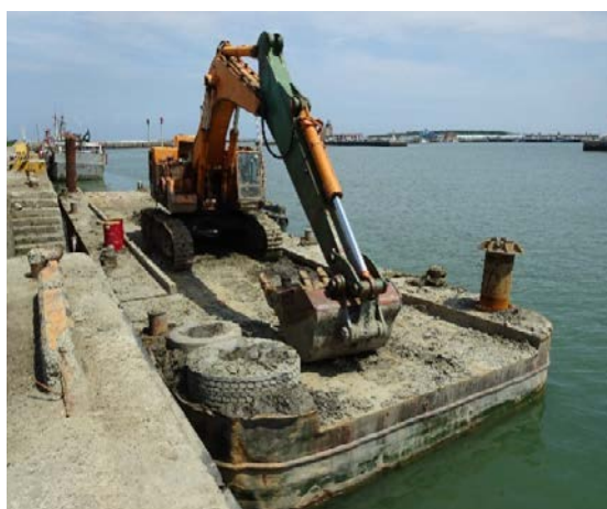
本工程挖泥船構造-平台船載運挖土機 (104 年 6 月 12 日拍攝)
