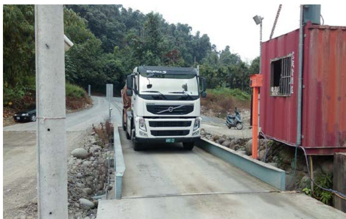
南投縣竹山鎮坪頂乾溪工區砂石車進出管制站情形 (南投縣政府提供)
