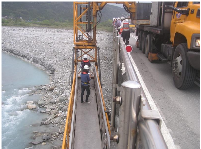
交通部公路總局辦理台 11 線馬太鞍溪橋橋梁檢測情形 （交通部公路總局提供）
