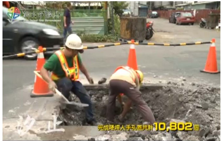
新北市汐止區道路挖掘及修補作業情形 (擷取自新北市政府工務局網站)
