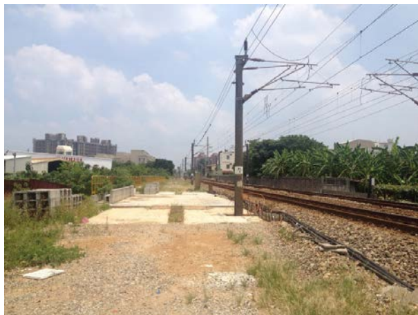
桃園鐵路臨時軌路基工程施工情形 （交通部臺灣鐵路管理局提供）
