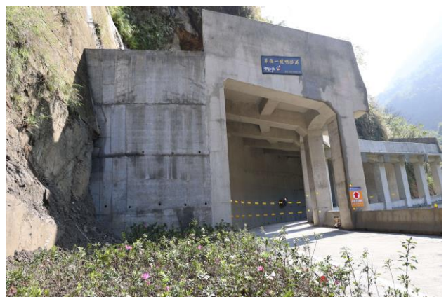
雲林縣縣道 149 甲線道路草嶺一號明隧道 (雲林縣政府提供)
