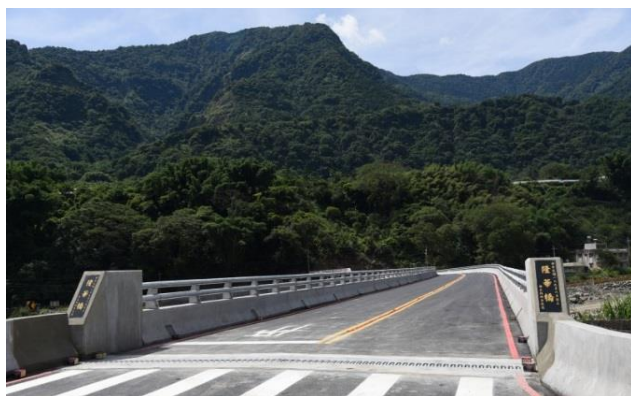
南投縣信義鄉投 93 隆華橋 (南投縣政府提供)
