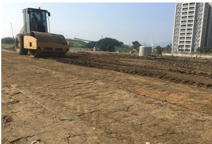
臺北市北投士林科技園區填土工程 (擷取自臺北市府工務局水利工程處網站)
