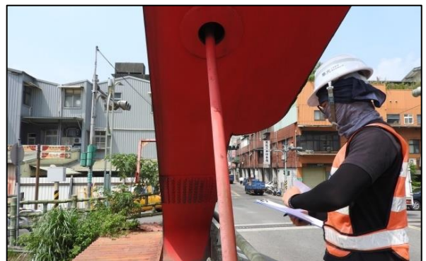
新北市汐止南陽大橋安全檢測 (新北市政府養護工程處提供)
