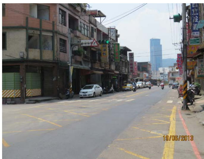
待拆遷建築物 (基隆市政府提供)
