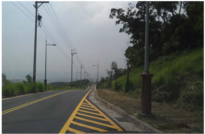
臺中市大肚區華南路新闢工程 (臺中市政府建設局提供)
