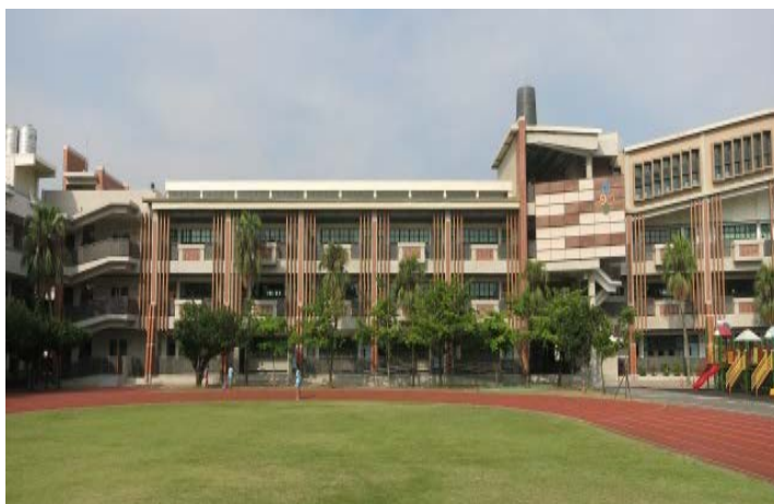
彰化縣花壇國小東棟校舍完工照片 (彰化縣政府提供)
