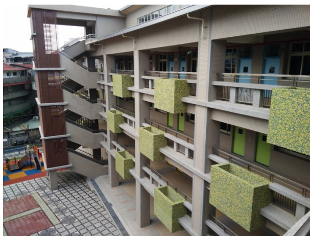
新北市永和區頂溪國民小學 2 期校舍整建暨共構地下停車場建築工程 (新北市永和區頂溪國民小學提供)
