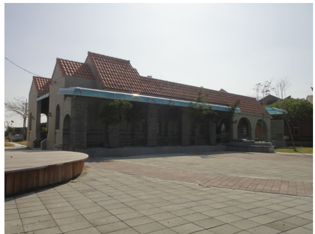
雲林縣口湖鄉埔北社區活動中心修繕後 （104 年 1 月 15 日拍攝）
