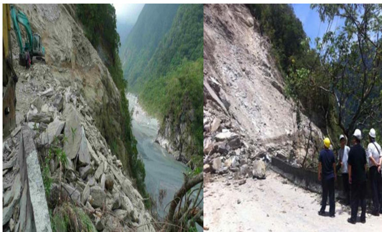
103 年度花蓮縣秀林鄉銅門村往慕古慕魚道路復建工程 (花蓮縣政府提供)
