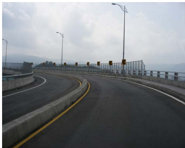
大華二路拓寬工程 (基隆市政府提供)
