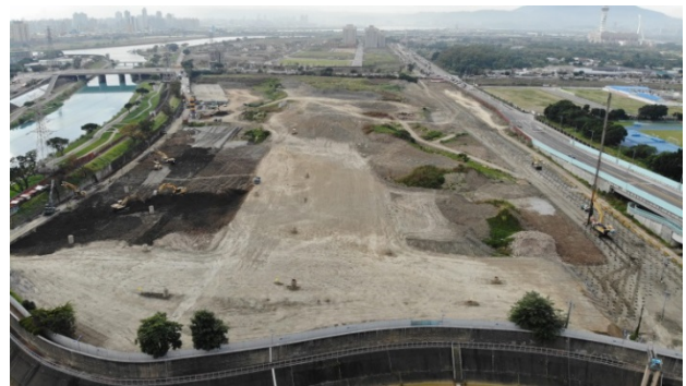
北投士林科技園區填土整地工程 (擷取自臺北市政府工務局水利工程處網站)
