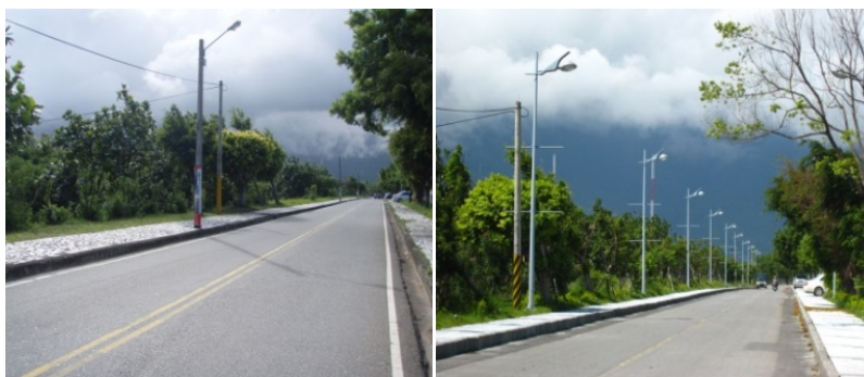
美崙工業區照明系統及人行空間更新前後情形
