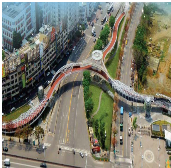
高雄市前鎮之星自行車橋 (高雄市政府工務局新建工程處提供)
