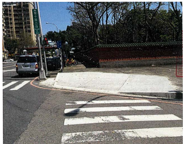
臺中市北區雙十路一力行路口無障礙斜坡道 (臺中市政府建設局提供)
