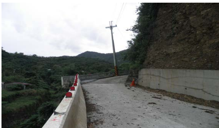
邊坡及農路改善後照片 （102 年 7 月 31 日現場拍攝）
