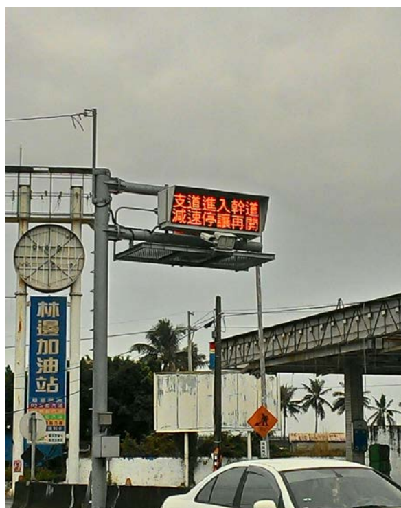
屏東縣台17線路側資訊可變標誌修復情形 (屏東縣政府警察局提供)
