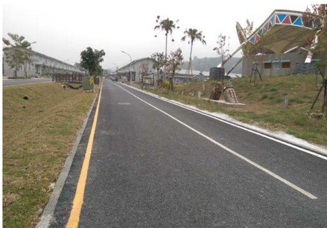
高雄市杉林大愛園區道路改善情形 (高雄市政府工務局提供)
