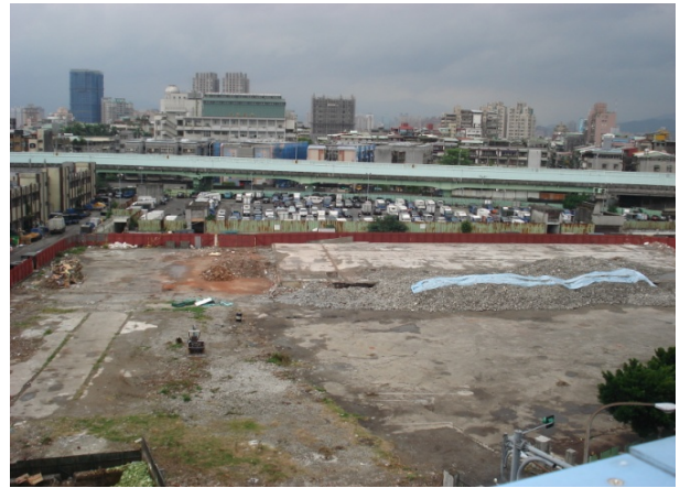
臺北市環南市場改建工程基地 (104 年 7 月 15 日拍攝)
