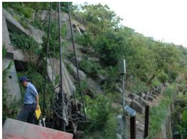
臺北市山坡地順向坡巡勘觀測情形 (臺北市政府工務局大地工程處提供)
