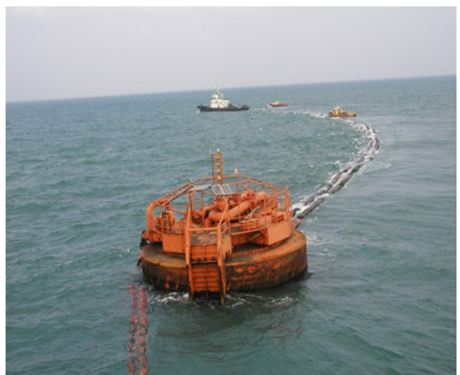
卸油輪停泊作業-工作船拖帶浮蛇管及浮筒 (台灣中油公司提供)
